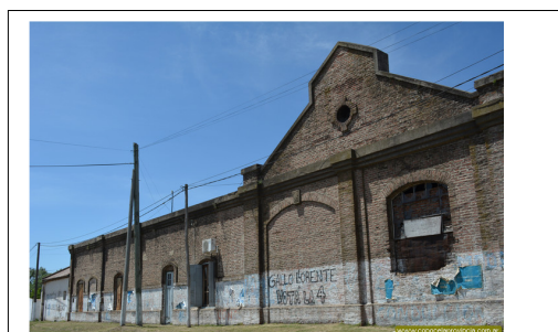
Talleres en El Provincial -9 de Julio (estado actual)
