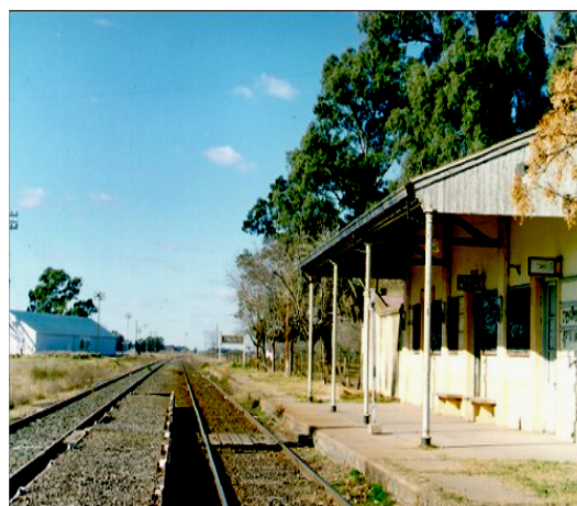
Estación Ferroviaria "French"
