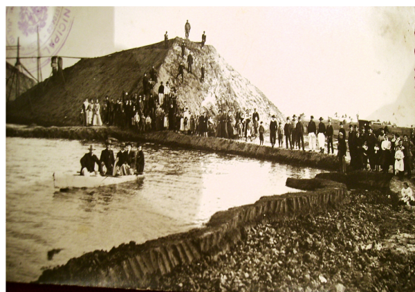
Esta foto que se encuentra en el Museo y Archivo Julio de Vedia, muestra el momento en que se está construyendo el altonivel del FCGBA que permitiría el cruce sobre las vías del F.C.Oeste., y en el reverso dice "Construcción terraplén F.C.G.B.Aires-1906"- Estudios Fotográfico "Adobato". Nueve de Julio-F.C.Oeste
