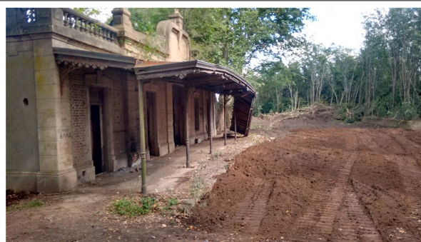
Estado actual de la Estación Baccay
